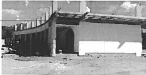
F1 Fachada principal
