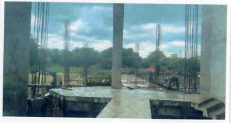
F3: Vista escaleras
