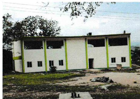
F2: Fachada lateral
