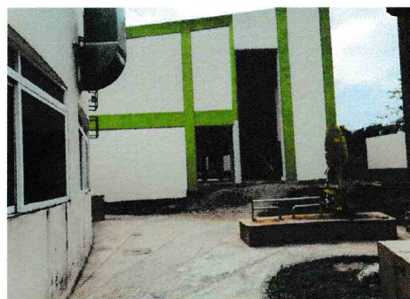
F4: Fachada lateral
