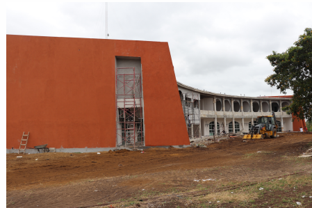
F4: Fachada lateral
