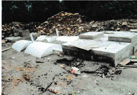
F1: Planta de tratamiento
