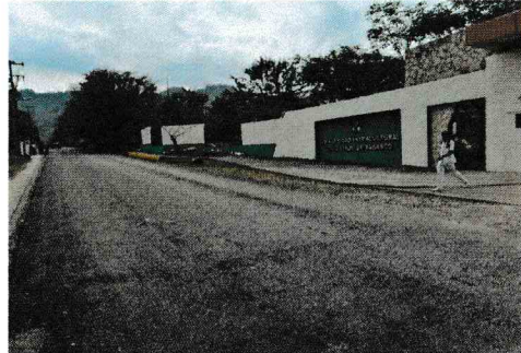
F1: Barda perimetral
