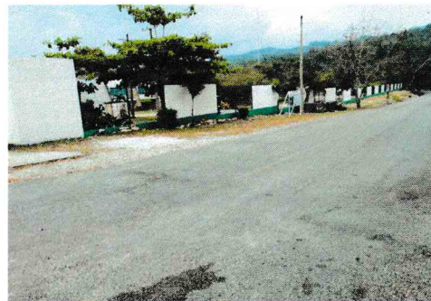
F2: Barda perimetral
