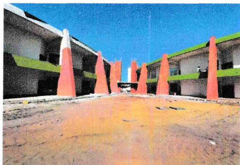
F1: Vista rampa
