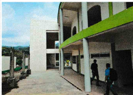
F3: Fachada lateral
