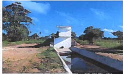
F4: Planta de tratamiento
