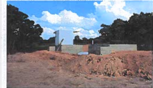
F5: Planta de tratamiento
