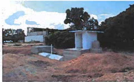
F4: Planta de tratamiento
