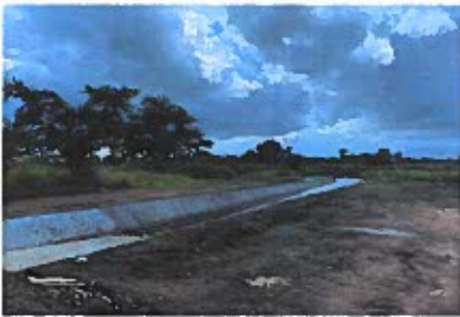
F3: Planta de tratamiento
