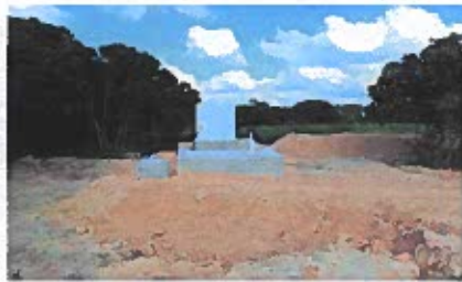
F3: Planta de tratamiento
