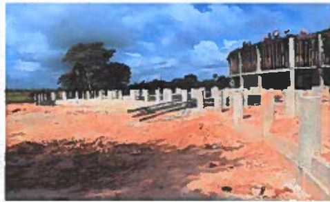
F1: Fachada principal
