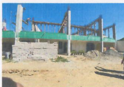
F3: Fachada posterior
