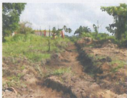
F3: Planta de tratamiento
