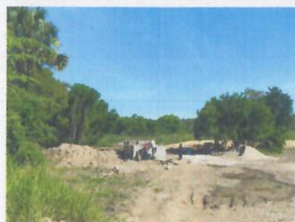
F3: Planta de tratamiento
