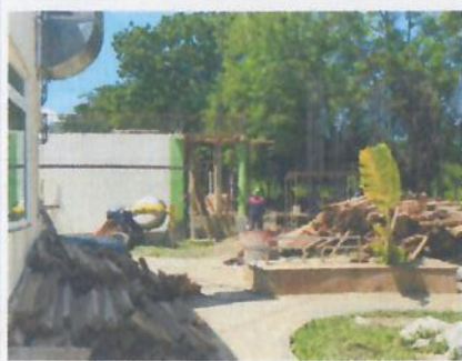
F3: Fachada lateral
