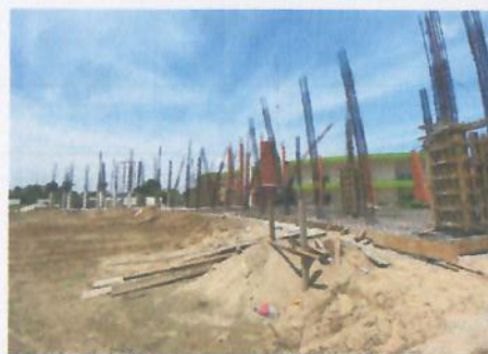
F4: Fachada lateral
