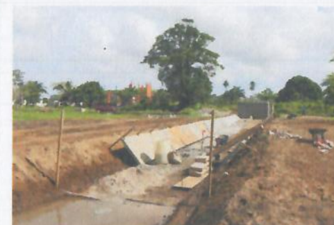
F5: Planta de tratamiento
