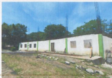
F2: Fachada lateral
