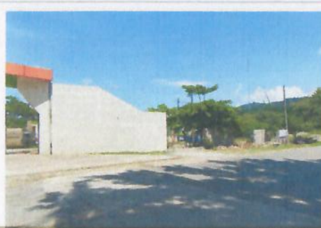
F2: Barda perimetral
