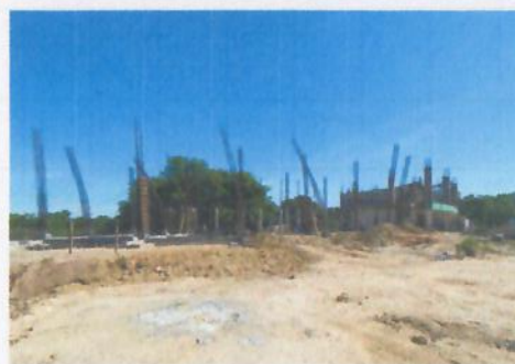
F4: Fachada posterior
