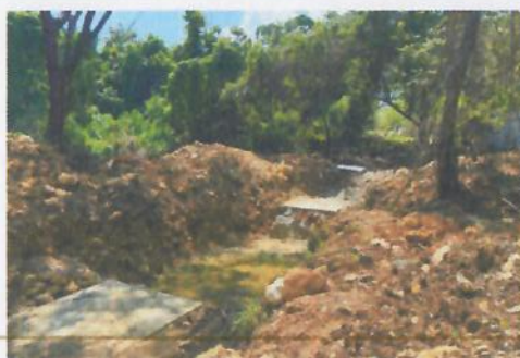
F2: Planta de tratamiento
