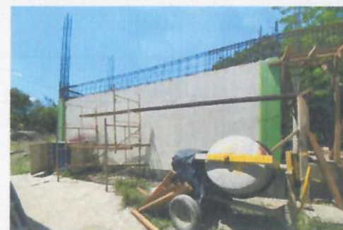
F5: Fachada posterior
