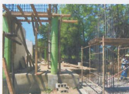
F4: Fachada lateral
