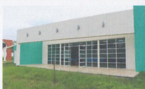
F2: Fachada lateral
