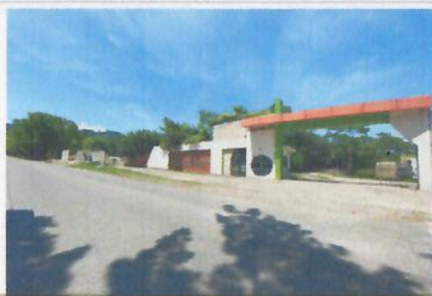
F1: Barda perimetral
