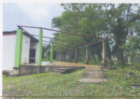
F2: Fachada lateral
