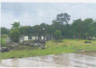
F3: Fachada Oeste
