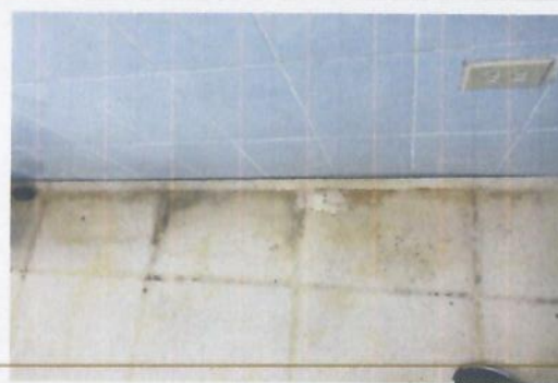
F2: Limpieza pisos
