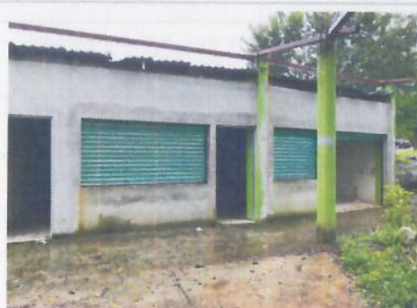
F4: Fachada lateral
