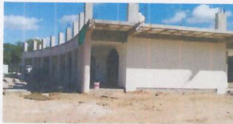
F1: Fachada principal
